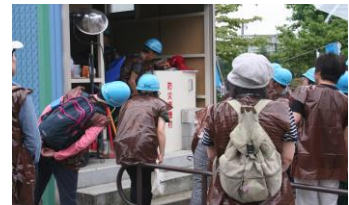
設置防災倉庫の点検・確認を行いました。
