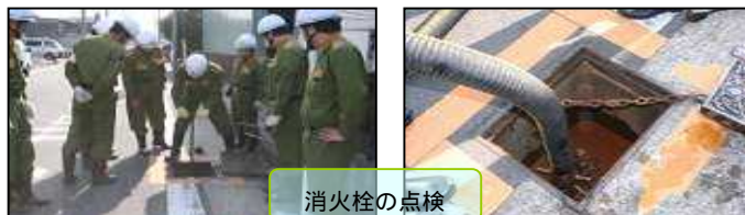
消火栓の点検
